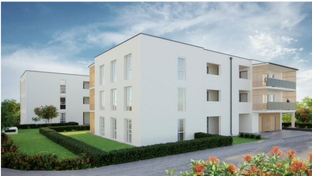
Wohnpark Primelweg Ansicht 3
